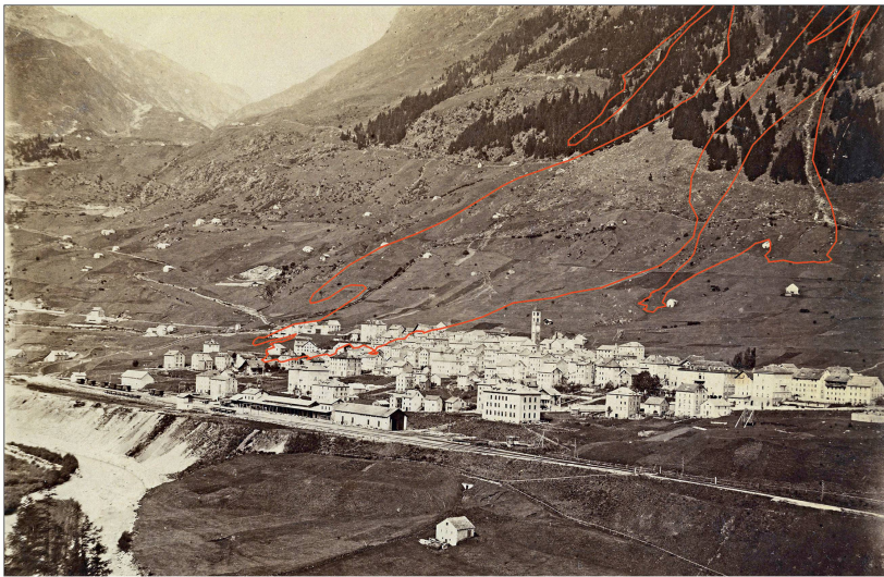
Abb 3 Fallbeispiel Rutschung Sasso Rosso, Airolo (TI) – Bild vor dem 28.12.1898. Projektion des Ablagerungsperimeters der Rutschung auf das historische Bild. Gut zu sehen sind die Gebäude, die durch die Rutschung verschüttet beziehungsweise zerstört wurden.
