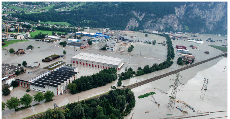
Hochwasser vom August 2005 im Industriegebiet Schattdorf. Foto: Baudirektion Uri
