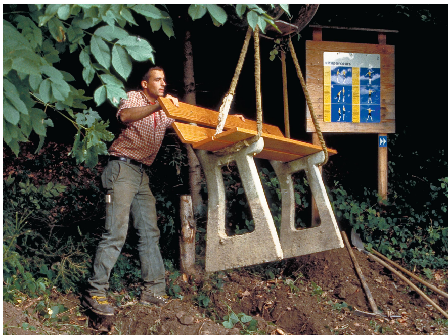
Abb 1 Verlegung eines Sitzbankes in Baden. Foto: Stadtförstamt Baden
