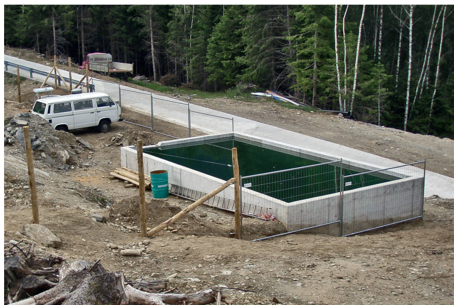
Abb 5 Das Lösswasserbecken Cramegn in der Gemeinde Soazza wurde im Jahr 2008 erbaut. Foto: L. Plozza
