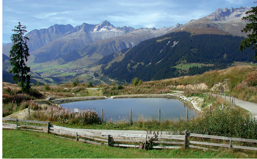
Abb 4 Der Lösswasserteich Stagias in der Gemeinde Medel wurde im Jahr 2001 zum Schutz der umfangreichen Vivian-Wiederaufforstungsflächen erbaut.
