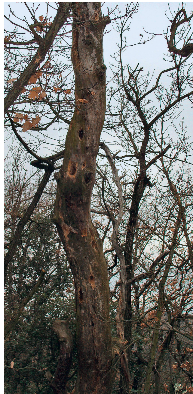
Fig. 2 Préservation d'habitats particuliers tels que le bois mort sur pied.
