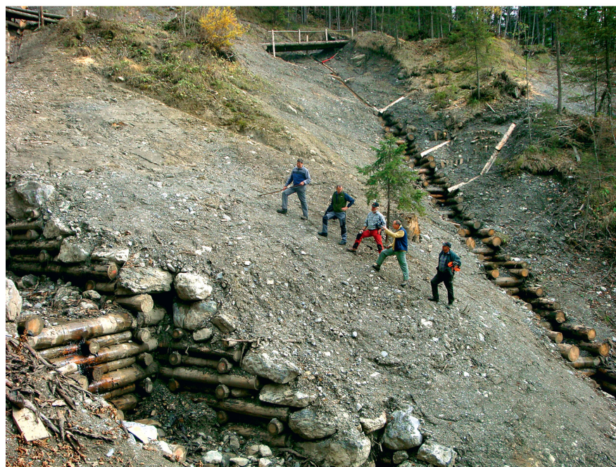
Abb 5 Vom Forstbetrieb ausgeführter Hang- und Bachverbau im Mühlwald, Engelberg.
