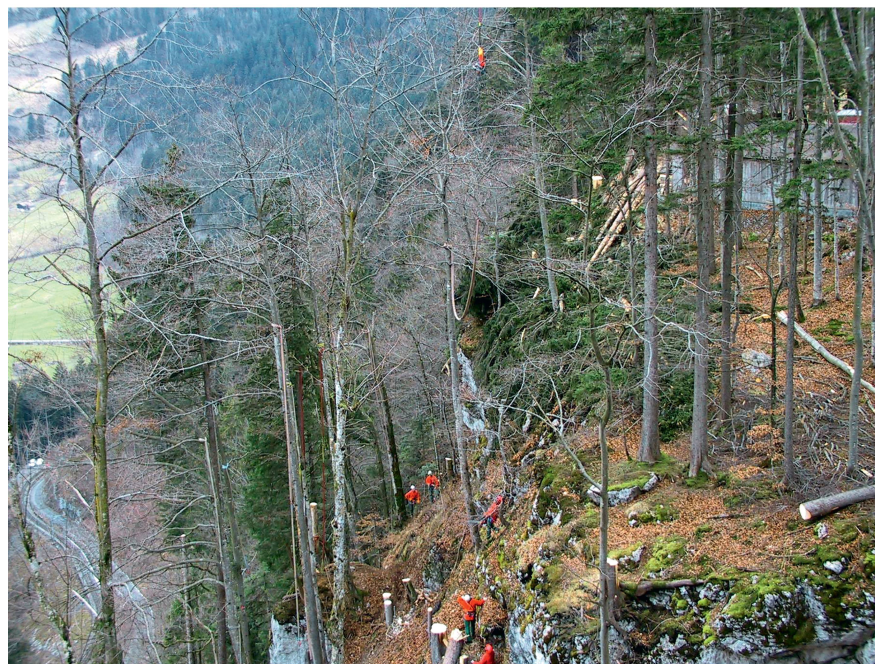
Abb 3 Schutzwaldpflege entlang von Bahn und Strasse am Brünig.
