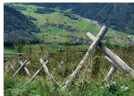
Lawinerverbauung Rigidal, Sitenwald. Foto: Sepp Hess
