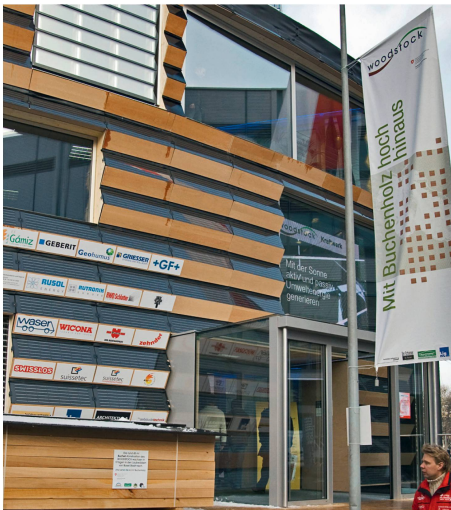
Le bâtiment «Woodstock» inauguré lors de la Swissbau à Bâle.
