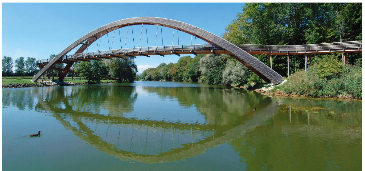
Abb 5 Zweckgemeinden – ein visionärer Brückenbau. Foto: Corinne Cuendet/Lignum (Holzbrücke bei Sugiez FR)
