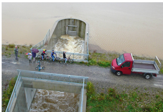
Abb 10 Hochwasser-rückhaltebecken Eichmatt beim Hochwasserereignis im August 2007.
