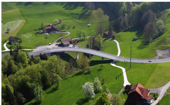
Abb 5 Neue und alte Brücke über den Sagelitobelbach.
