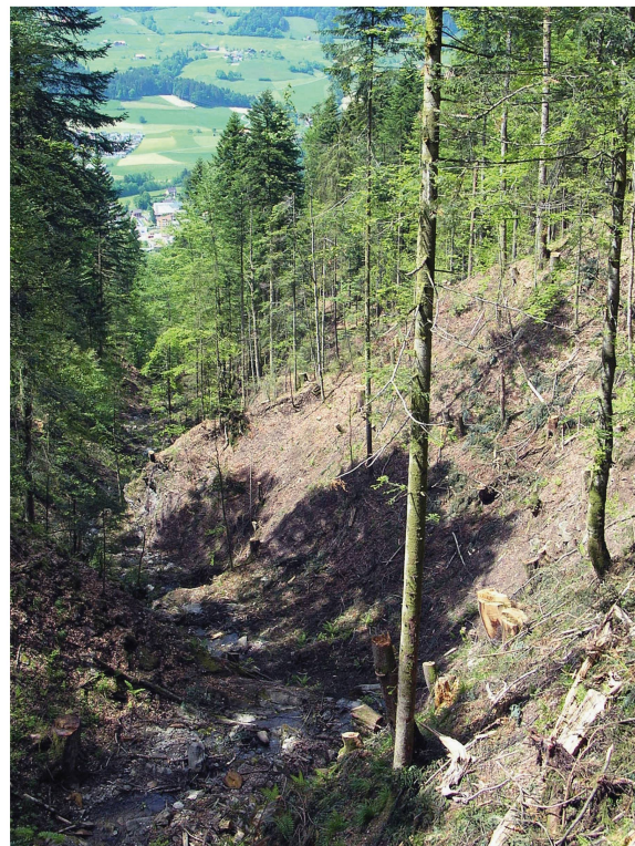
Abb 6 Trüebebach, Gemeinde Schüpfheim, nach dem Eingriff: Die Gefahrenträger sind entfernt, der Bachlauf von Schwemm- und Totholz befreit.
