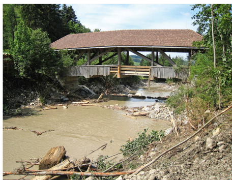
Brücke über den Grossbach (SZ). Foto: Christian Rickli (WSL)
