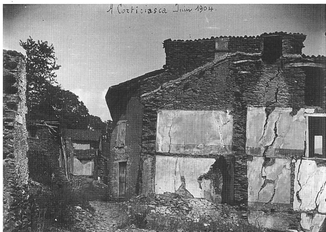
Figura 4: Corticiasca case distrutte a causa del franamento del pendio, 1904.
