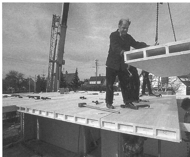
Abbildung 13: Einsatz von Hohlkastendecken, Lignatur AG, Waldstatt.
