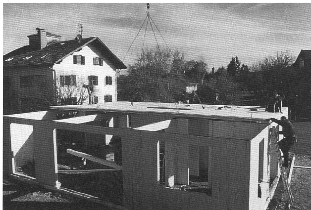
Abbildung 10: Fertigteilhaus aus Massivholzplatten, Schilliger Holz AG, Küssnacht.
