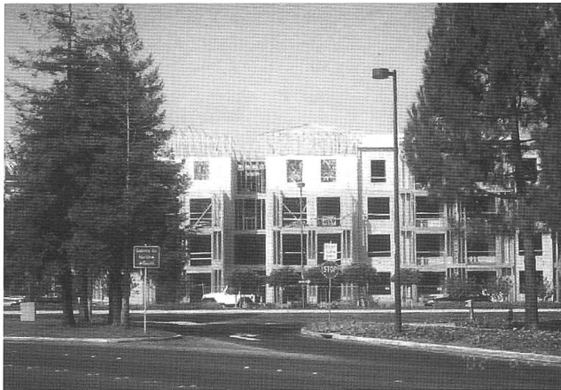
Abbildung 18: Haus in Holzrahmenbauweise mit OSB beplankt (San Francisco, USA).
