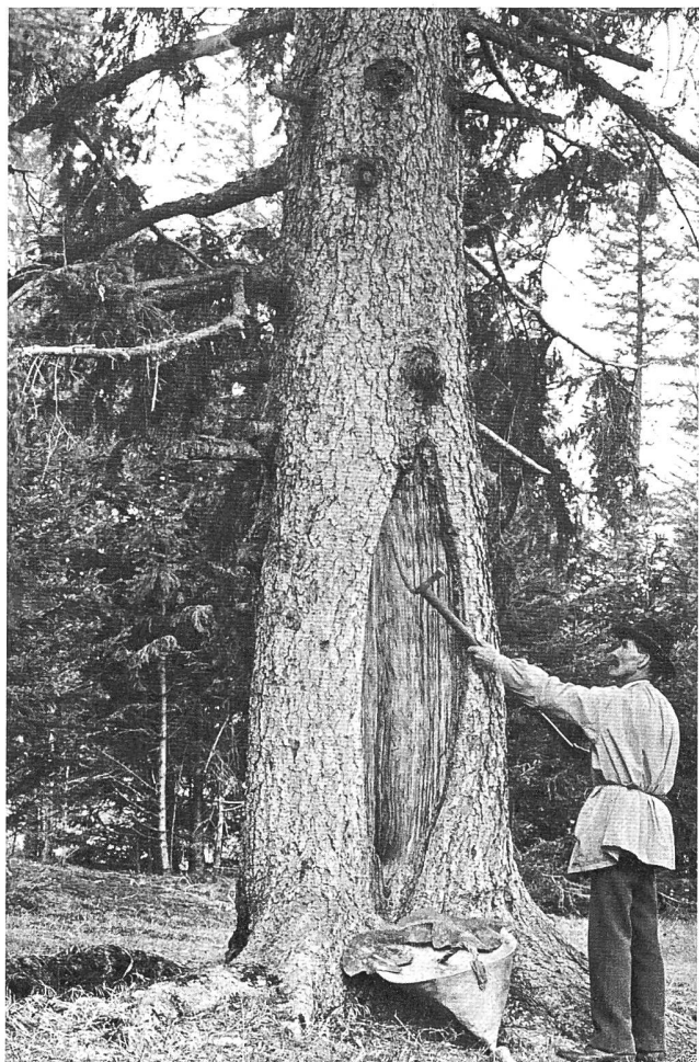
Abbildung 7: Harzer an der Arbeit auf der Wytweide von Malleray. Man beachte die Werkzeuge zum Abkratzen und Auffangen des Harzes, in SCHÖNENBERGER 1912, Abb. 1.
