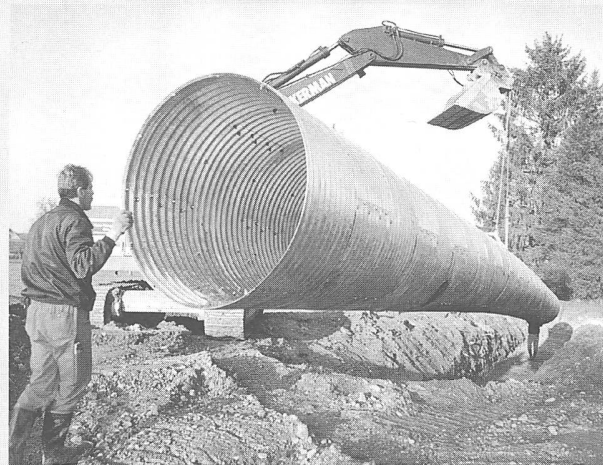
Montage eines HAMCO-Wellstahlrohres in Ermensee, Kt. Luzern.
