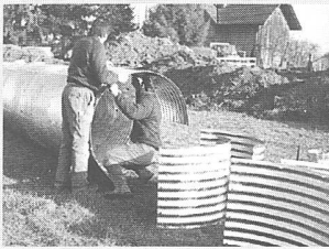
Montage eines HAMCO-Wellstahlrohres in Ermensee, Kt. Luzern.
