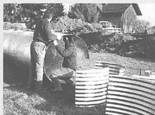
Montage eines HAMCO-Wellstahlrohres in Ermensee, Kt. Luzern.
