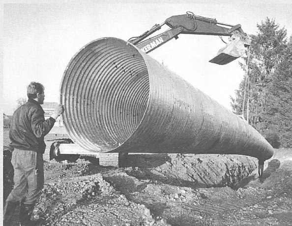
Montage eines HAMCO-Wellstahlrohres in Ermensee, Kt. Luzern.
