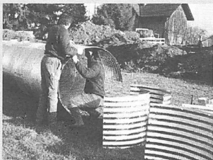
Montage eines HAMCO-Wellstahlrohres in Ermensee, Kt. Luzern.
