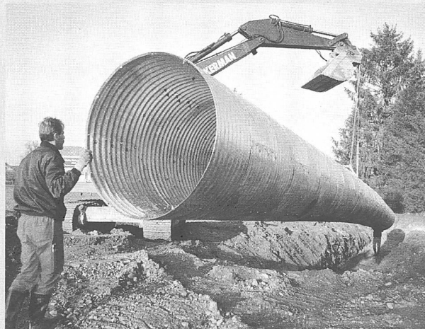
Montage eines HAMCO-Wellstahlrohres in Ermensee, Kt. Luzern.
