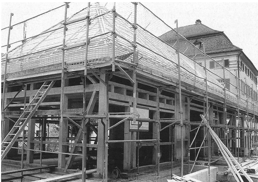
Abbildung 1: Bau des Heizungsgebäudes für das Kloster Fischingen, in dem eine Schnitzelheizung errichtet wird. Oktober 1998. Foto ARMIN BONT.
