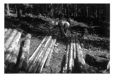
Abbildung 6. Vorkonzentration des Holzes an der Seillinie infolge der Harvesteraufarbeitung. Die Vorkonzentration führt zu einer beträchtlichen Leistungssteigerung beim Rücken. (Foto Forstverwaltung Mayr-Melnhof-Saurau).
