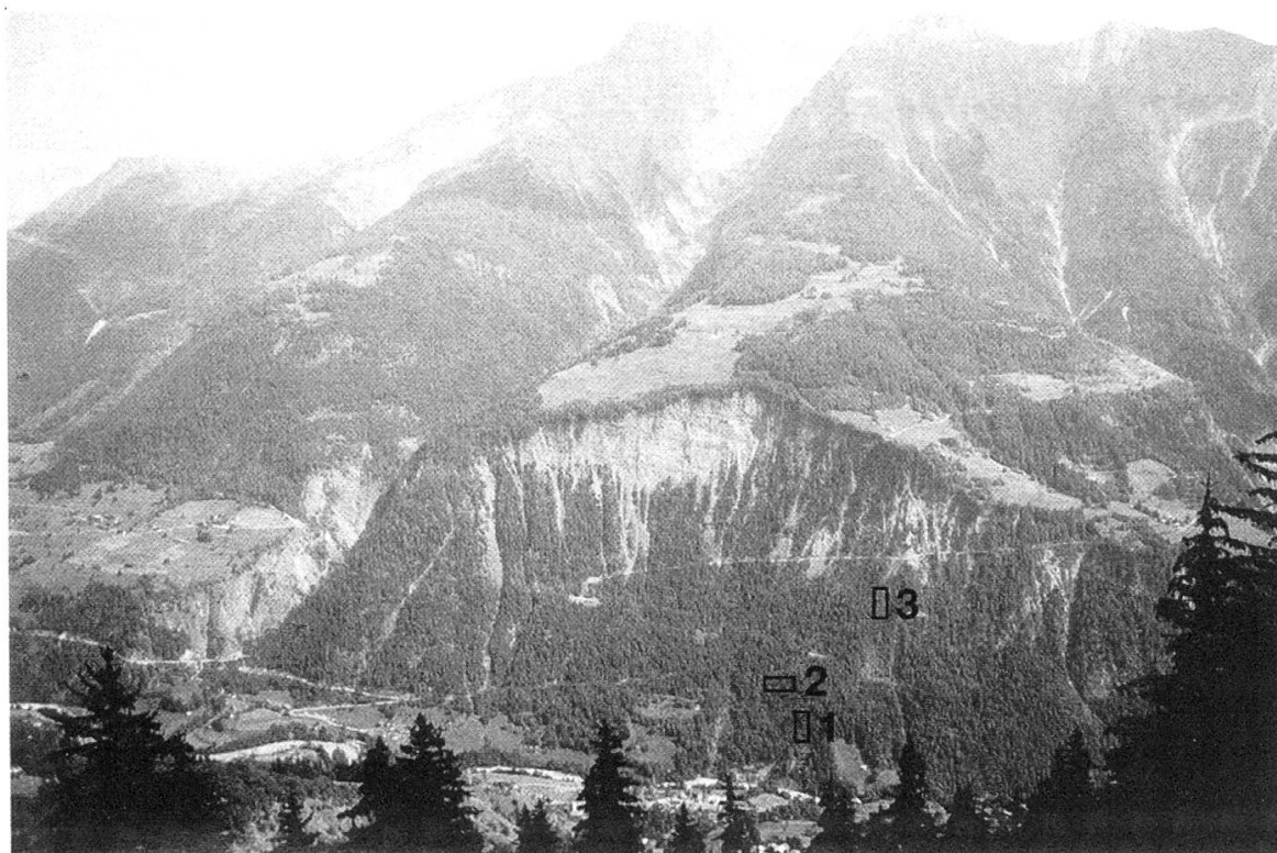
Abbildung 1. Ansicht des Rutschgebietes Brunjini vom gegenüberliegenden Hang oberhalb Mörel. Eingezeichnet sind die drei Untersuchungsflächen. Unterhalb der Zahl 3 ist das Trasse der Druckleitung erkennbar, die mittlerweile in den sicheren Fels verlegt wurde.
