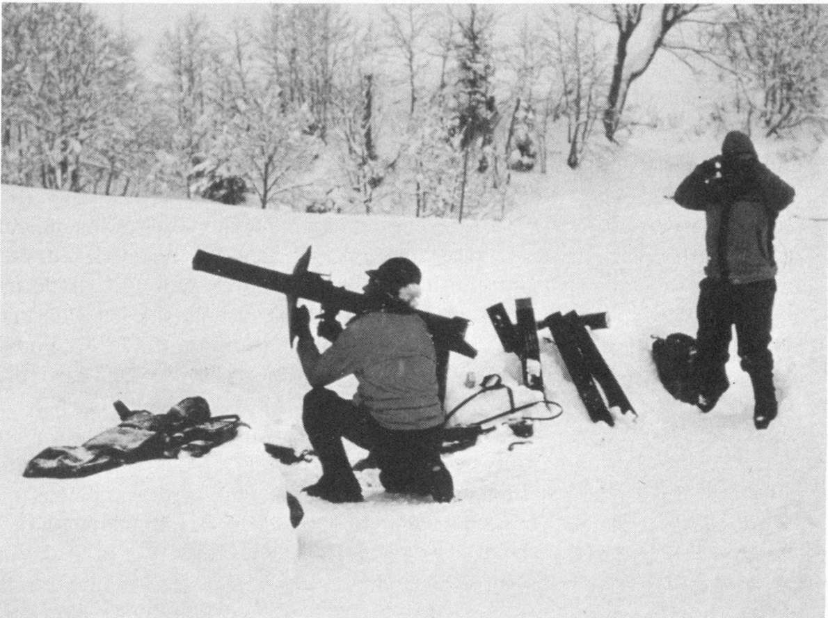
Abbildung 9. Raketen-Rohr-Beschuss von Schneehängen, die für den vorliegenden Strassenabschnitt gefährliche Lawinen verursachen könnten. Diese prophylaktische Massnahme wird häufig während oder nach dem Schneefall bei gesperrter Strasse ausgeführt.
