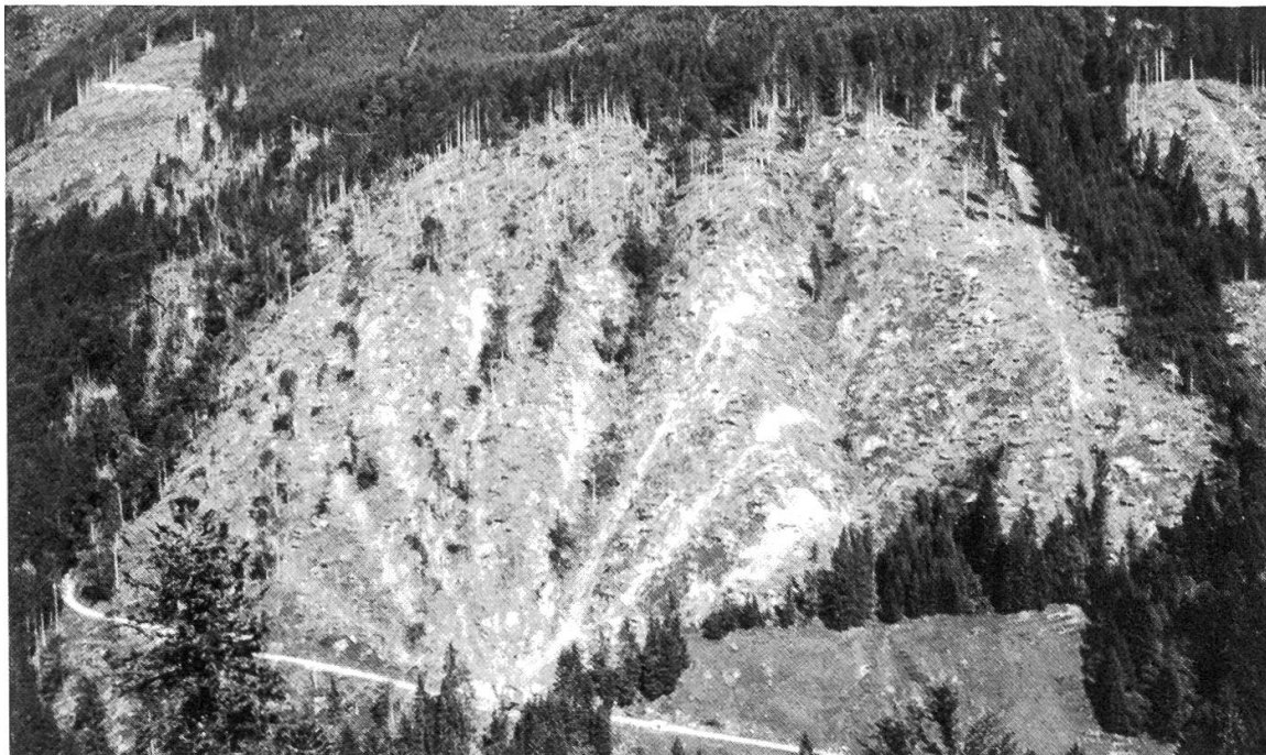
Abbildung 2. Versuchsfläche im Niderental bei Schwanden (GL). Im obersten Flächenteil bleibt das Sturmholz liegen. Das mittlere Drittel ist als Variante mit Räumung und Naturverjüngung, das unterste Drittel als Variante mit Räumung und Bepflanzung vorgesehen (19. August 1991).
