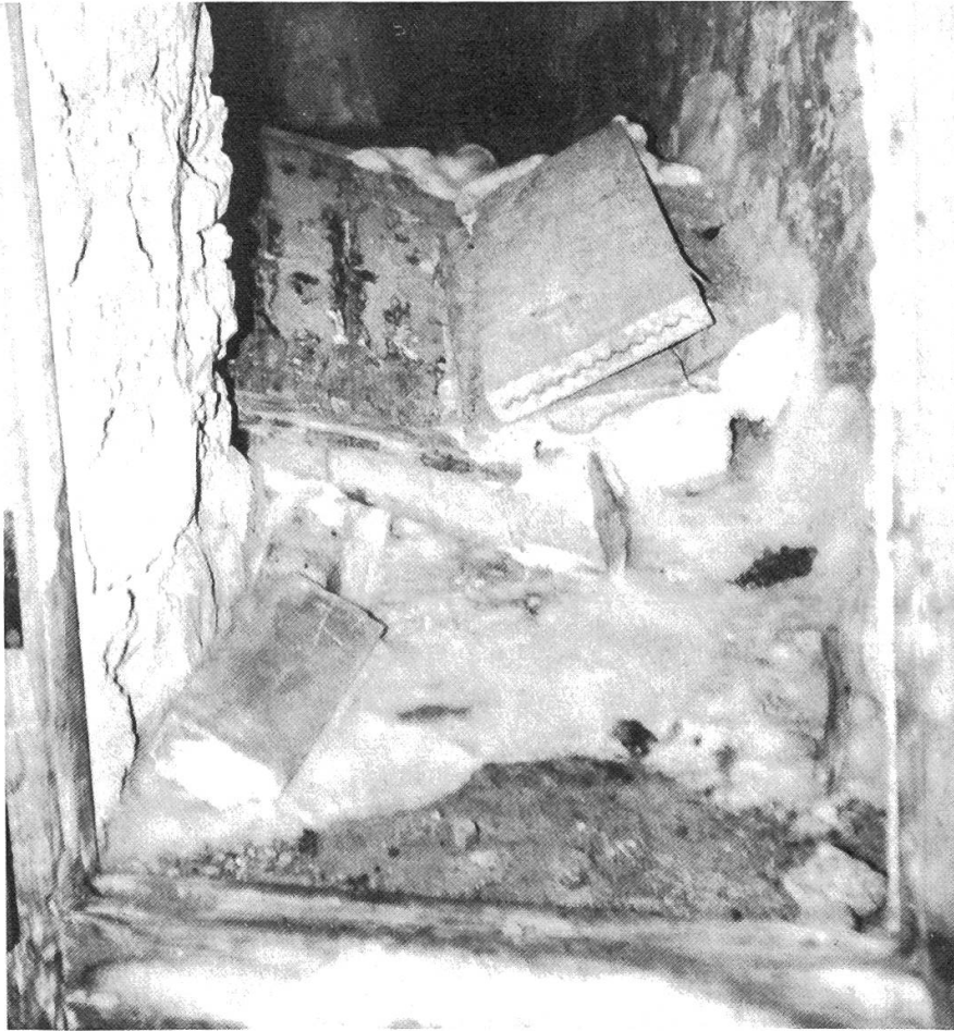
Abbildung 2. Wo Pilze gedeihen: Echter Hausschwamm im muffig/feuchten Milieu, auf totem Holz.
