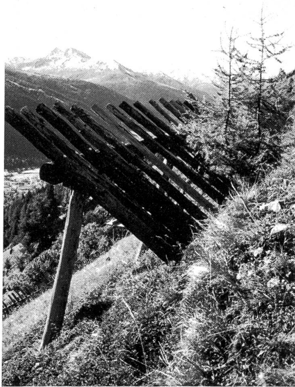
Abbildung 4. Lawinerverbauung im Aufwuchsgebiet.
