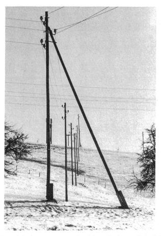
Abbildung 2. Leitungsnetz aus druckimprägnierten Rundhölzern.
