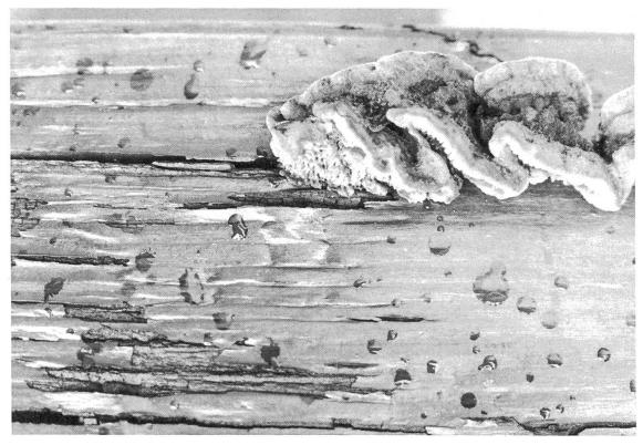
Abbildung 6. Durch Feuchtestau bedingter Pilzschaden (Gloeophyllum ssp.) an einem tragenden, bewitterten Holzbauteil.
