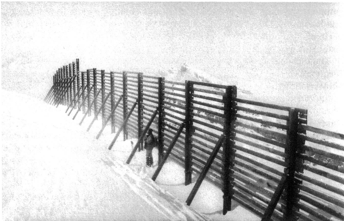
Abbildung 1. Verwehungsverbau Hinterrugg (Probeverbau und Hauptverbau, April 1992).
