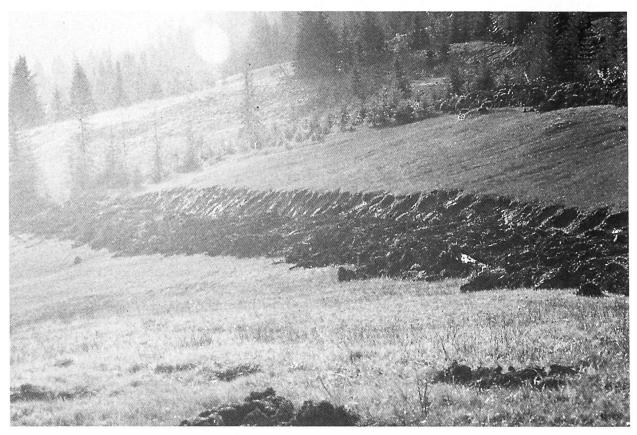
Abbildung 8. Bild einer im Bau befindlichen Waldstrasse im Kanton Luzern. Das Trassee der Strasse verläuft mitten durch ein grossflächiges Hangmoor. Foto: A. Grünig.
