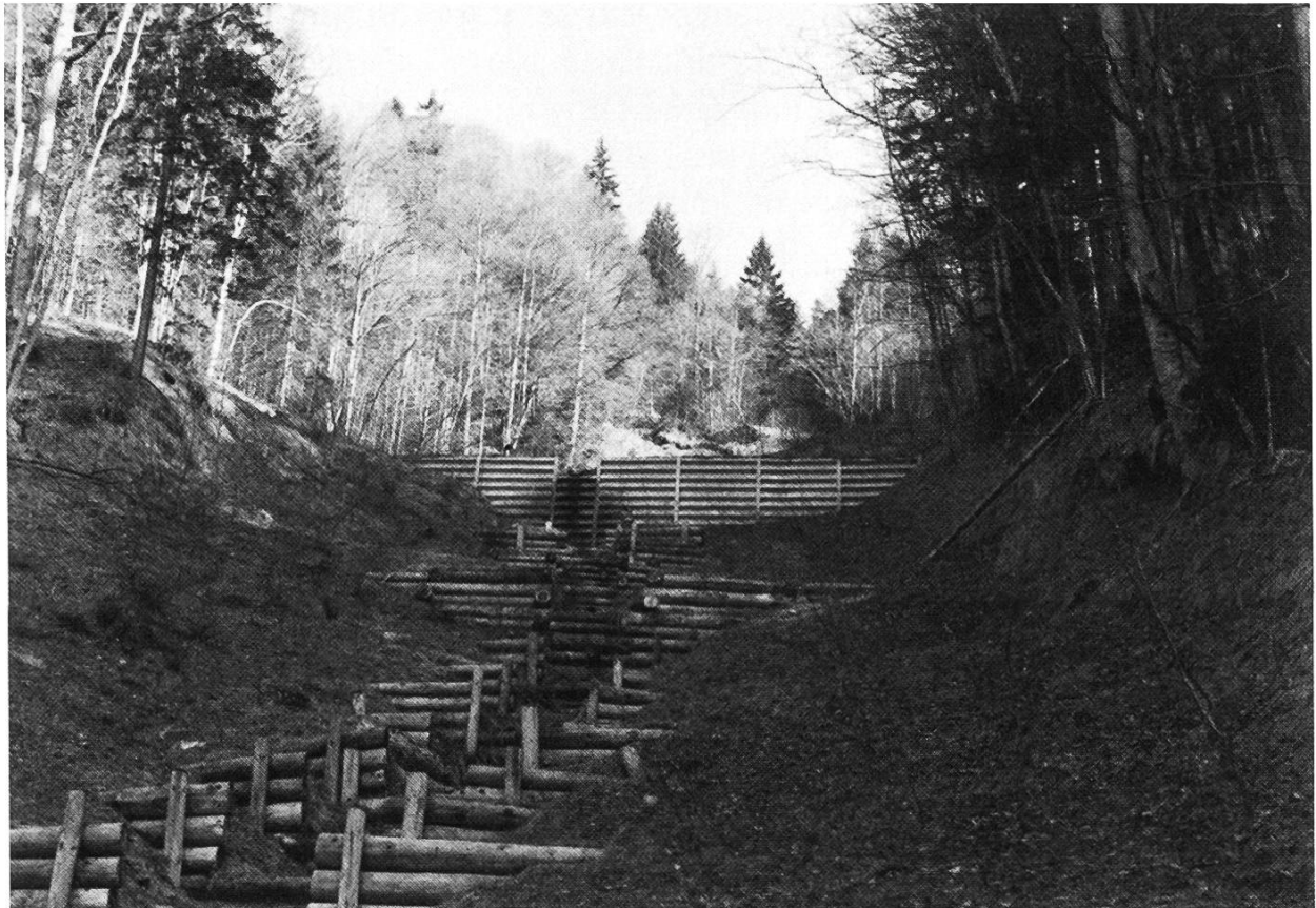
Abbildung 4. Transportzone mit einfachen Holzsperrern, Holzkastensperren und Kassetten-Stützwand.
