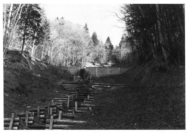
Abbildung 4. Transportzone mit einfachen Holzsperren, Holzkastensperren und Kassetten-Stützwand.
