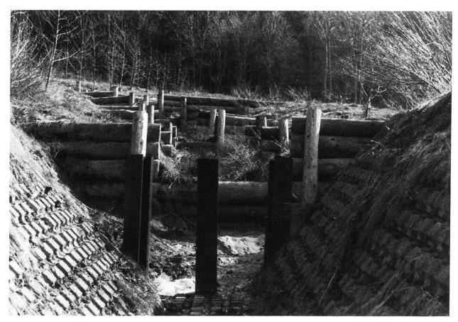
Abbildung 3. Übergang von den einfachen Holzsperren zum offenen Graben mit UK-Steinen.
