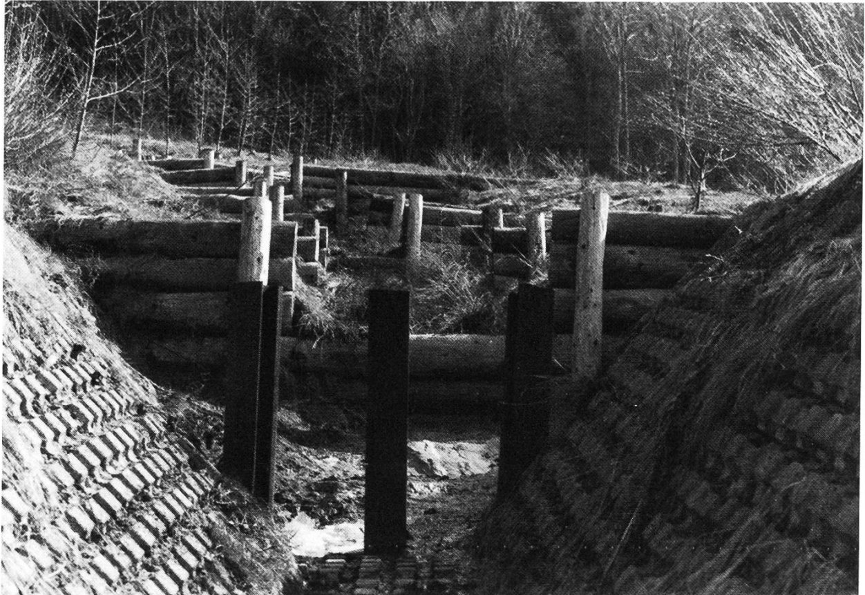
Abbildung 3. Übergang von den einfachen Holzsperrern zum offenen Graben mit UK-Steinen.
