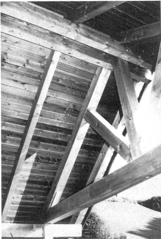
Abbildung 7. Dachkonstruktion aus Weisstannensholz.
