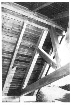
Abbildung 7. Dachkonstruktion aus Weisstannenholz.
