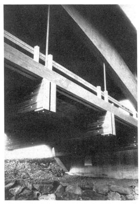
Abbildung 8. Druckimprägniertes und verleimtes Weisstannenschnittholz im Brückenbau
