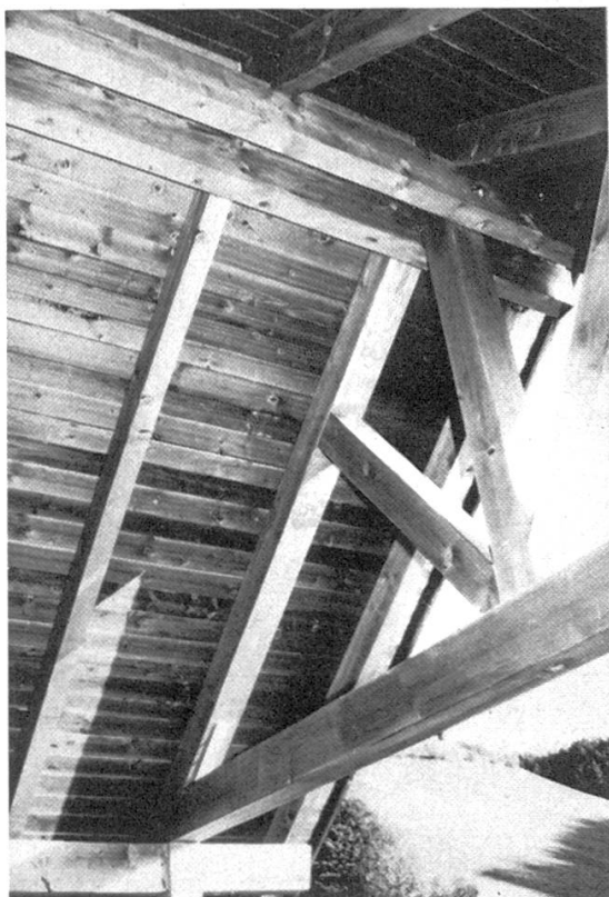
Abbildung 7. Dachkonstruktion aus Weisstannenhholz.
