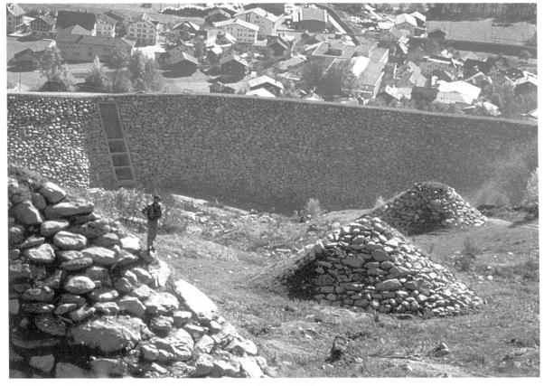
Abbildung 3. Auffangdamm mit Bremskegeln (Trun, GR).
