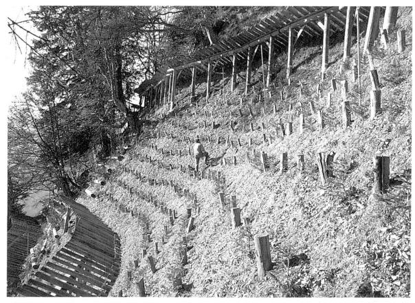
Abbildung 7. Versuchsfläche für Schneegleitschutzmassnahmen, Detailansicht (Bleisa/Pusserein, GR).
