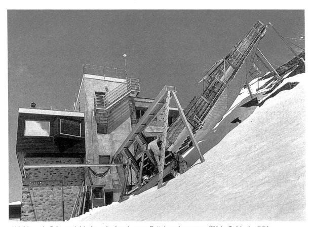
Abbildung 4. Schneegleitbahn mit eingebauten Brückenelementen (Weissfluhjoch, GR).
