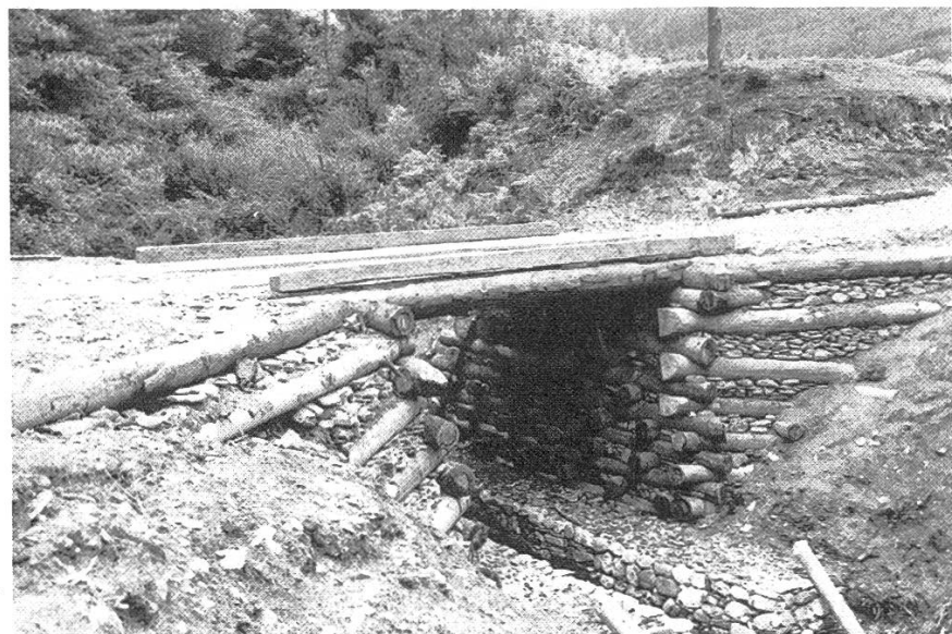
Abbildung 4. Brückenbau mit lokal vorhandenen Materialien (Bild P. Moser).
