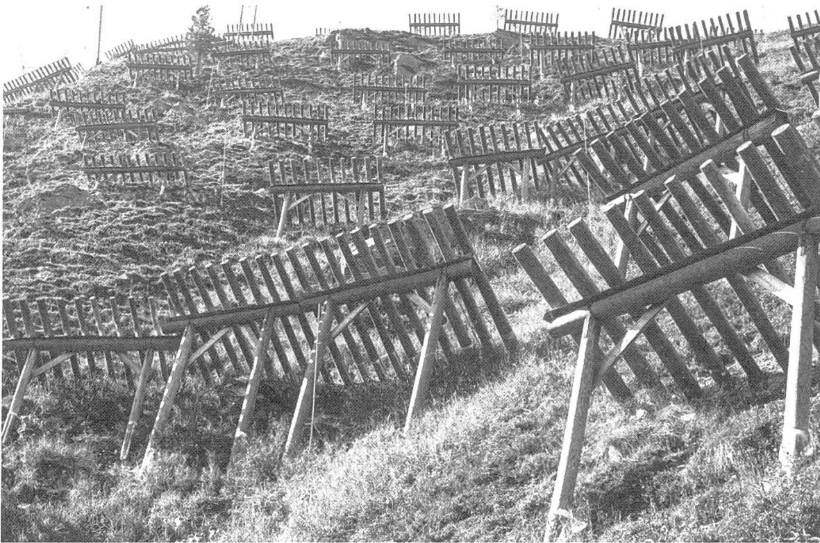
Abbildung 5.2. Versuchsgebiet Stillberg, Variante Verbau aufgelöst; temporärer Stützverbau mit Holzschneerechen Typ EISLF.
