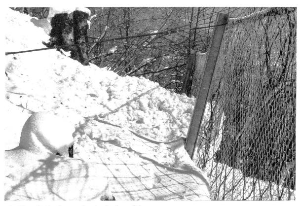
Abbildung 3: Abgefangene Lawine in einem Schneenetz.
