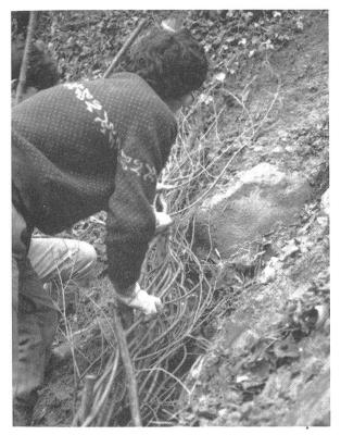
Abbildung 2. Flechtzaun: Im schaufeltiefen Graben werden Weidenpfähle in einem Abstand von etwa 1,00 m eingerammt. Dazwischen werden Weidenäste geflochten und anschliessend mit dem Aushubmaterial wieder eingedeckt. So sind die Äste gegen Austrocknung geschützt und können sich zu kompleten Pflanzen regenerieren.
