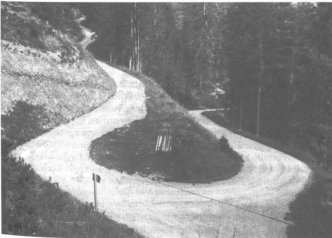
Abbildung 3. Sehr gut dem Gelände angepasste Linienführung. Wendeplatte und Abzweigung liegen ideal. (Foto Calörtscher)
