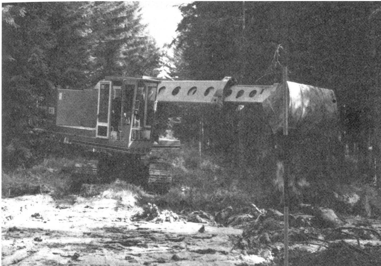
Abbildung 1. Gradall bei der Erstellung des Planums auf einem schlecht tragfähigen Boden (Photo: Firma Charles Keller)
