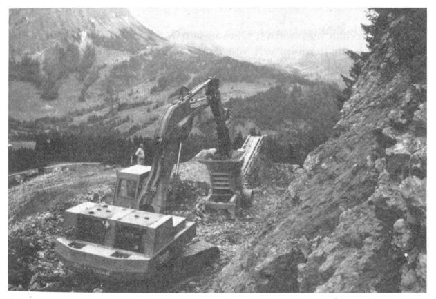
Abbildung 4. Hydraulikbagger und «mobiler» Backenbrecher bei der Aufbereitung von Nagel-fluhmaterial zu Kies-Sand für die Tragschicht (Photo: Firma H. Renggli, Malters)
