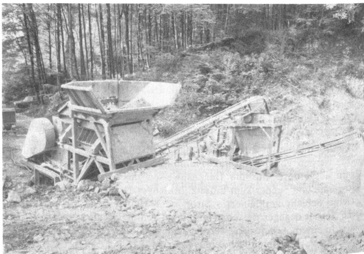
Abbildung 3. Backenbrecher (links) und Hammermühle (rechts) zur Aufbereitung von Trag- und Verschleisschichtmaterial (Photo: Firma H. Renggli, Malters)
