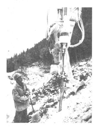
Abbildung 2. Zusatzbohreinrichtung am Menzi Muck (Photo: Firma H. Renggli, Malters)
