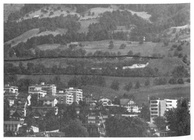
Abbildung 3. Kiesgrube Tschümperlin Küssnacht. Zwischen den Strichen wurden in den letzten Jahren über 1 Million m³ Kies abgebaut, ohne dass eine Wunde in der Landschaft sichtbar ist. Die bereits abgebauten Flächen sind auf dem sichtbaren Hintergrund begrünt und mit Bäumen bepflanzt.
