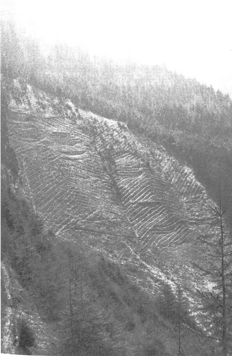
Abbildung 2. Linksseitiger Hang: Die nachträglich erfolgten Rutschun- gen sind noch deut- lich sichtbar, eben- so die Verbauung mit Drahtstein- kasten (Foto 1980).
