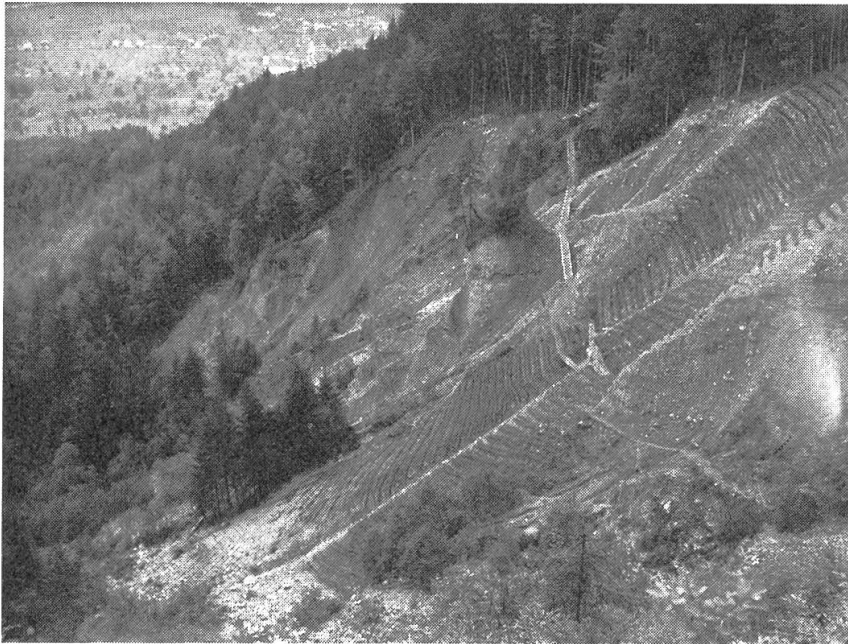
Abbildung 1. Rechtsseitiger Hang während der Sanie- rung (Foto: M. Kaiser, etwa 1945).
