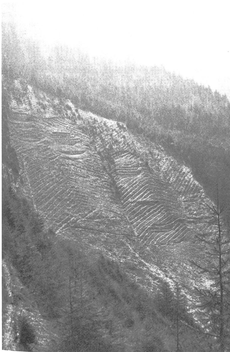
Abbildung 2. Linksseitiger Hang: Die nachträglich erfolgten Rutschun- gen sind noch deut- lich sichtbar, eben- so die Verbauung mit Drahtstein- kasten (Foto 1980).
