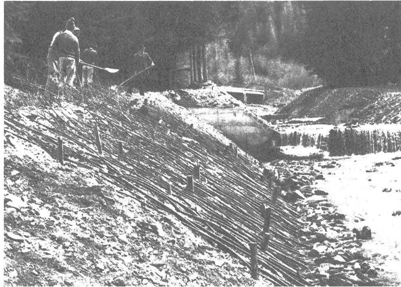
Abbildung 1. Ufersicherung mit Weidenspreitlagen, Lasankenbach- Hinterläsen, Südtirol.
