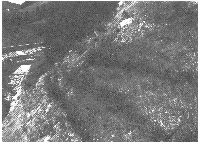
Abbildung 2. Hangsicherung mit Buschlagen, links unten eine Trocken-Steinmauer mit Fugen- bepflanzung durch Weidensteckhölzer, Gader/Pedrares.
