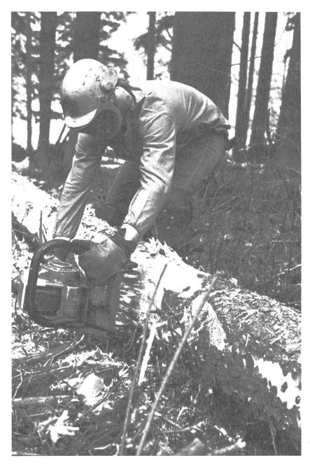
Abbildung 1 Motor-manuelle Stammholzentrindung am Hiebsort. Die Gesamtbelastung des Waldarbeiters ist infolge statischer Arbeit und ungünstiger Körperhaltung unverantwortlich gross. Der «Biber» ist nicht das geeignete Mittel zur «Mechanisierung» auf der Bestandesfläche. (Foto:
