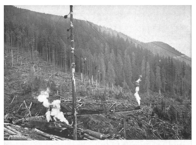
Bild 2. 1936: Kahlschlag mit Zuziehen des nutzbaren Holzes auf kurze Distanz mit dem «Spar-tree-System». Transport mit der Waldeisenbahn, die mitten in die exploitierte Fläche hineingeführt wird. 1974 ist der «Spar-tree» im Versuchswald der Universität von Britisch-Kolumbien auf ein ehemaliges Tank-Chassis aufmontiert.
