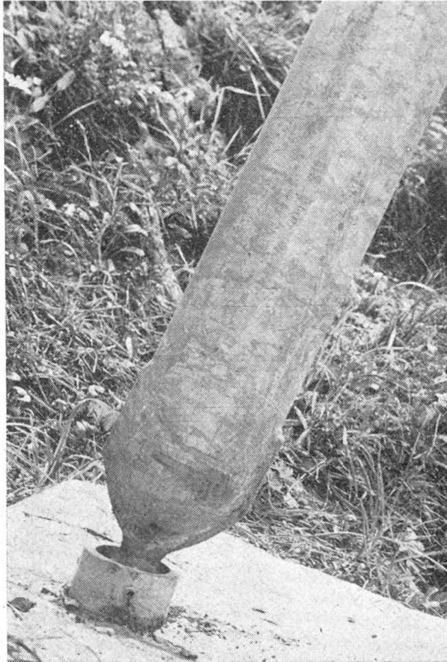
Kugelgelenkstütze für Schneesetze. (Photo: H. Oppliger, Glarus)
