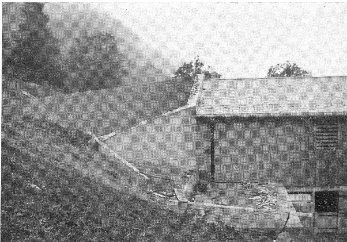
Spaltkeil an einem Stall in Luchsingen. (Photo: E. Blumer, Glarus)
