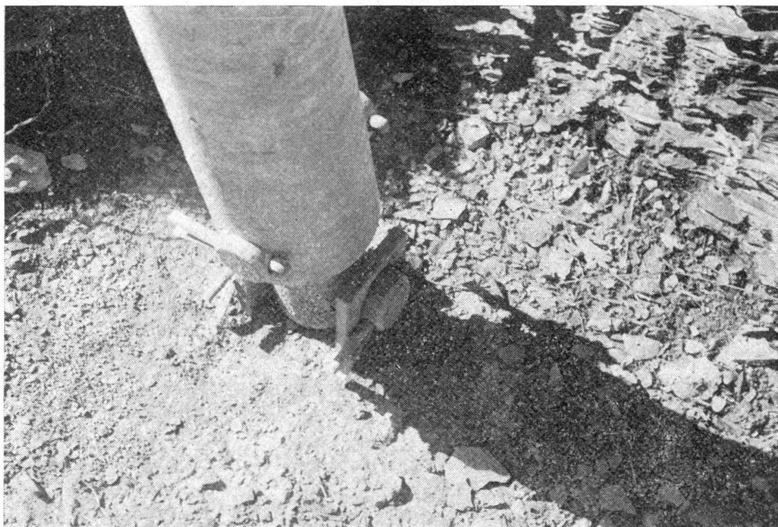
Kreuzgelenkstütze für Schneesetze. (Photo: H. Oppliger, Glarus)
