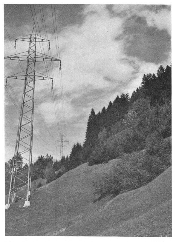
Wegen der am Hangfuss bestehenden Hochspannungsleitung können in der Fallinie des Hanges keine Holztransportseile mehr nach der Talsohle gespannt werden (Gemeinde Haslen). (Photo: OFA Glarus)
