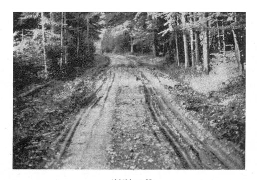
Abbildung 2 Zu Punkt 5: Alte, ins Wegnetz aufgenommene Strasse, welche durch den Baustellenverkehr völlig zerstört wurde.
