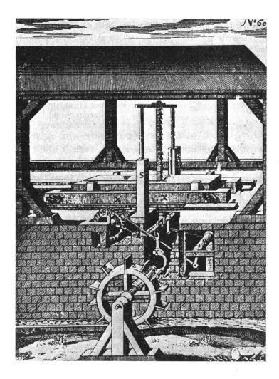
Abbildung 5 Alte Wassersägemühle mit Seilvorschub
