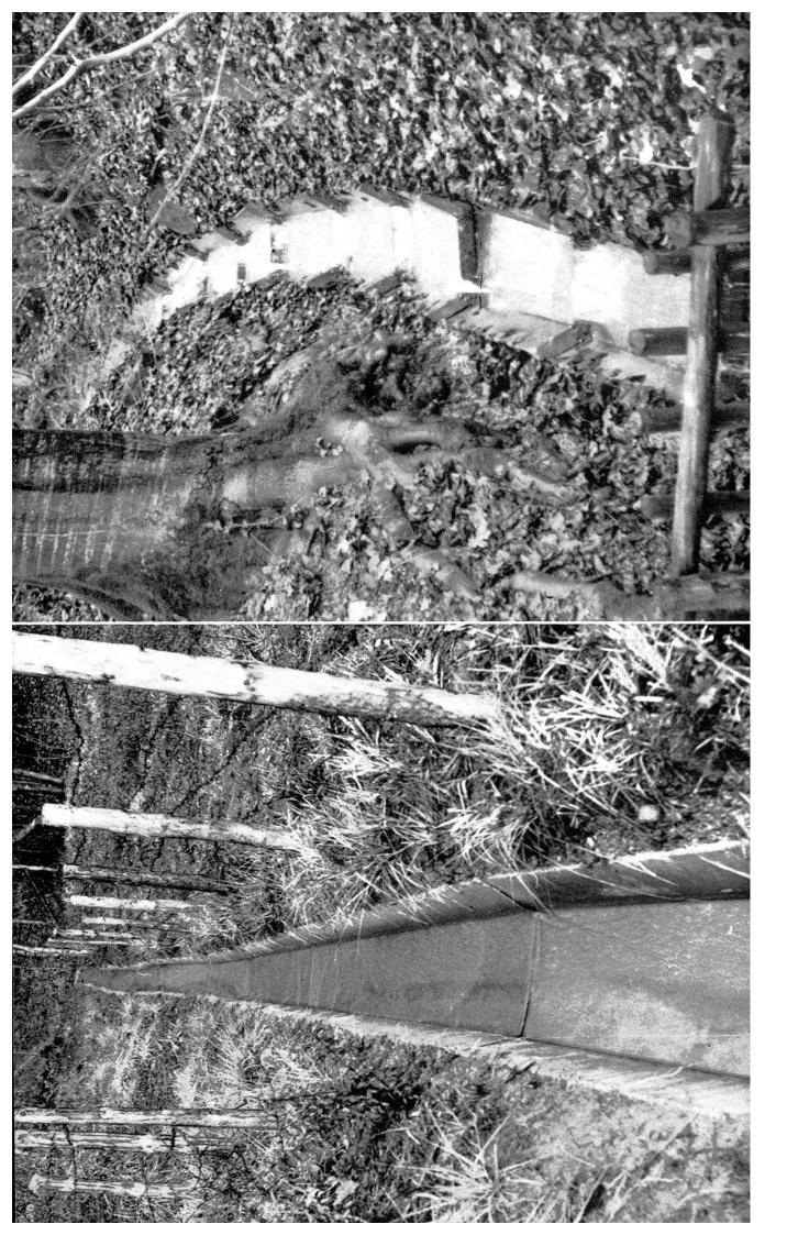
Allgemeines: Die glatte Innenseite führt zu hohen Abflußgeschwindigkeiten, was vor allem bei starken Richtungsänderungen berücksichtigt werden muß. Die hohe Abflußgeschwindigkeit begünstigt die Selbstreinigung der Schalen.
