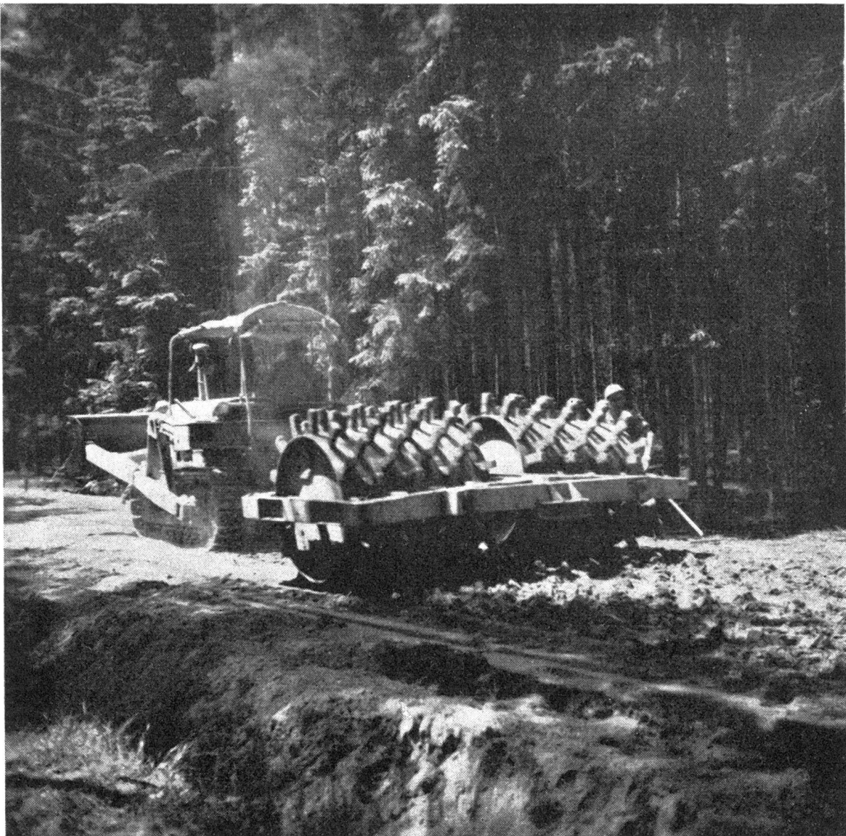
Abbildung 1 Schafffußwalze, von Raupenschlepper gezogen
