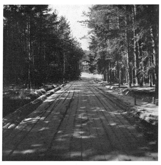
Abbildung~2 Straßenoberbau, durch Gummiradwalze in Verdichtung begriffen
