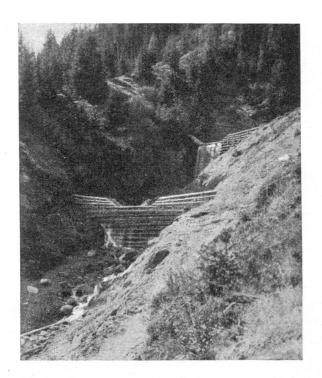
$Abbildung \ 1$  Steinkastensperren zur Geschiebeberückhaltung und Erosionsbekämpfung in einem Wildbachgraben
