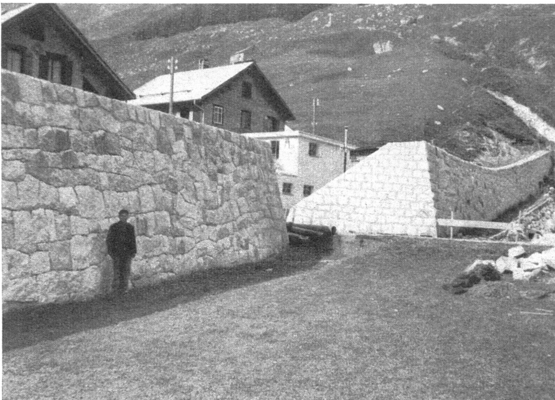
Straßendurchgang zwischen den Mauern II und III
