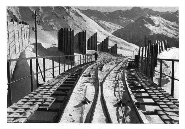
Fig. 6. Ausweichstelle an der obern Sektion der Davos-Parsenn-Bahn mit Leitwänden zur Vermeidung von Schneeablagerungen.
